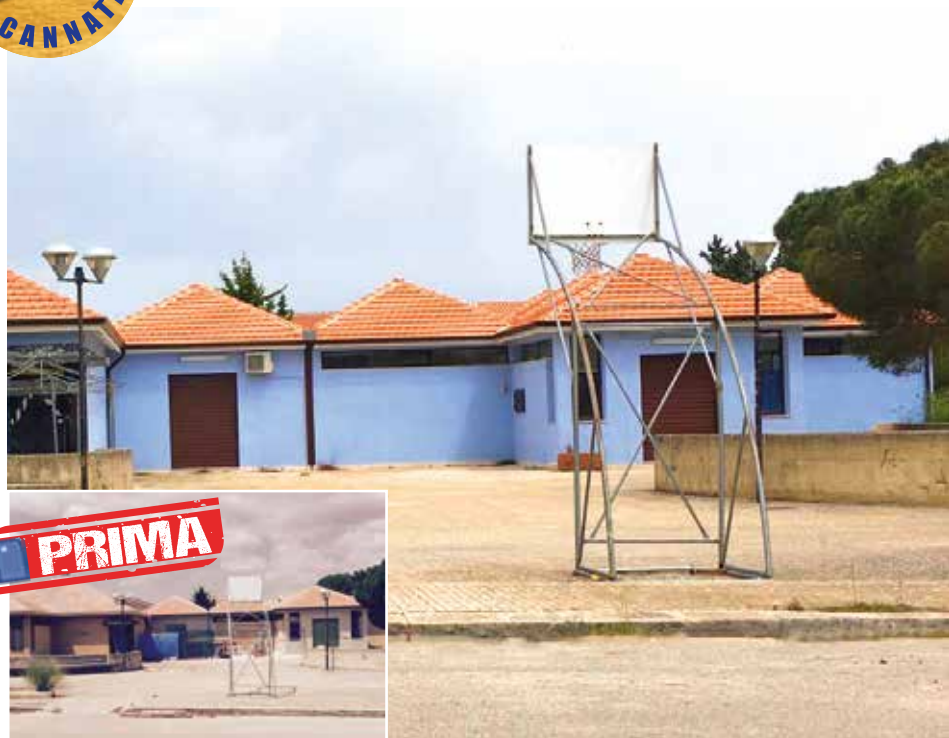
Ristrutturazione dei locali Ex Cupole di Avola Antica.
