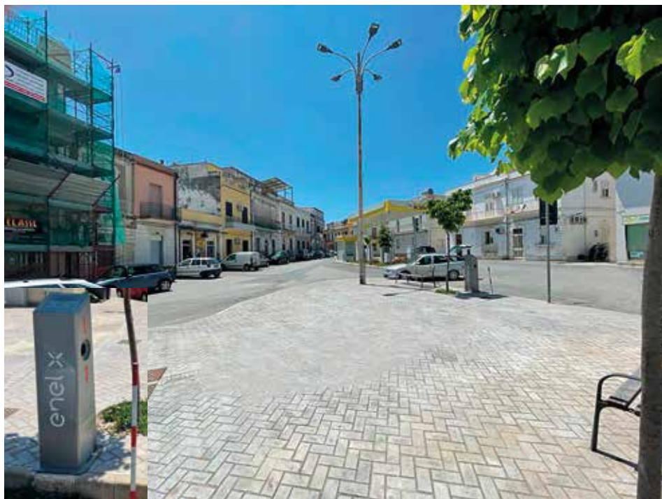
Riqualificazione e manutenzione di piazza F. Corridoni con installazione colonnina EnelX.
