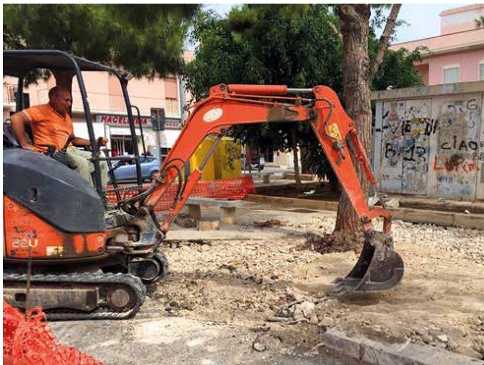
Riqualificazione e manutenzione di piazza Denaro.
